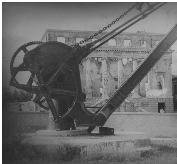
Il Palazzo del Municipio di Viareggio in via Regia distrutto dai bombardamenti aerei, fotografato da Franco Signorini dopo la liberazione.
